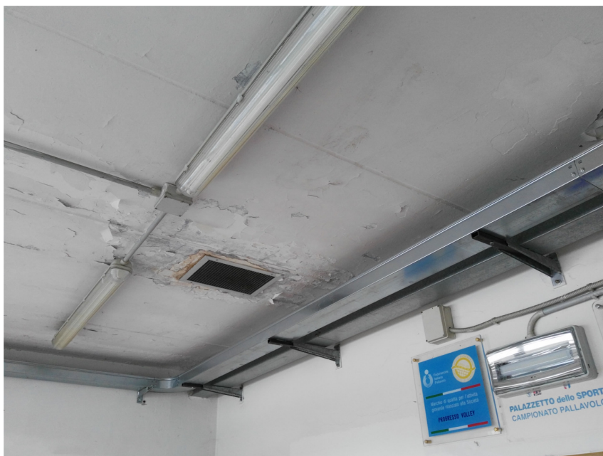
Foto 6: particolare dell'infiltrazione
