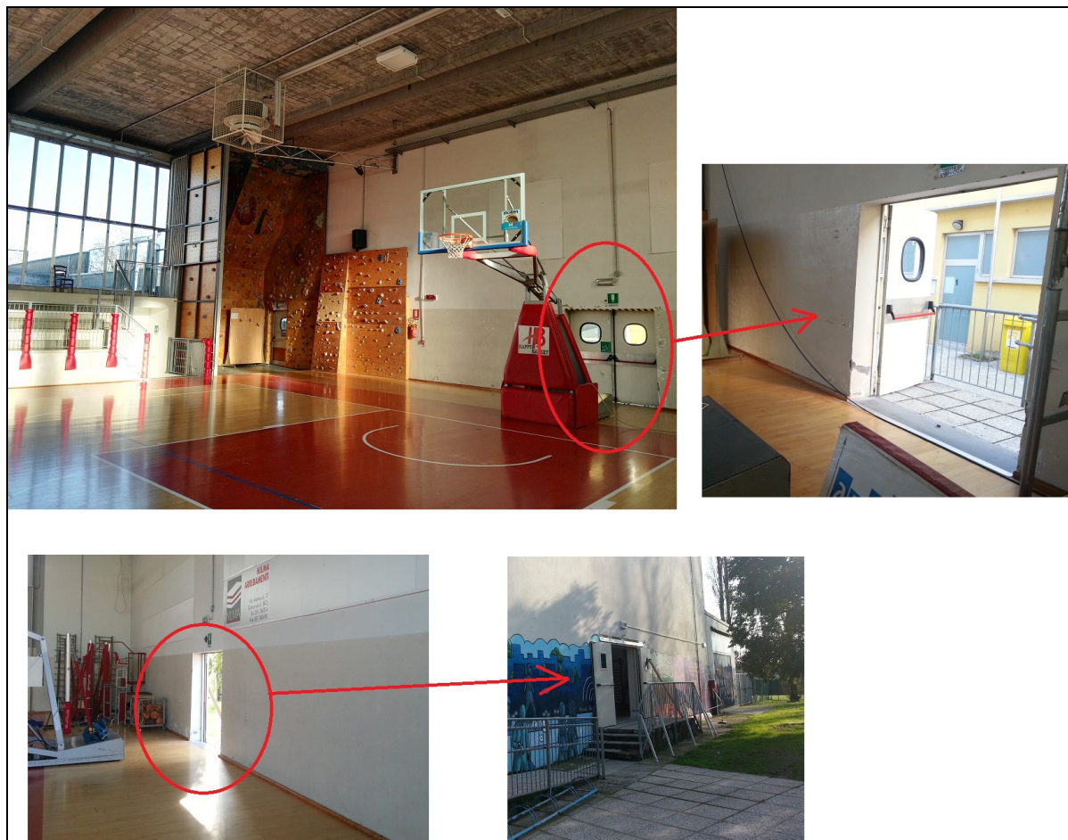
Collage di foto 1: particolare delle 2 porte da sostituire
