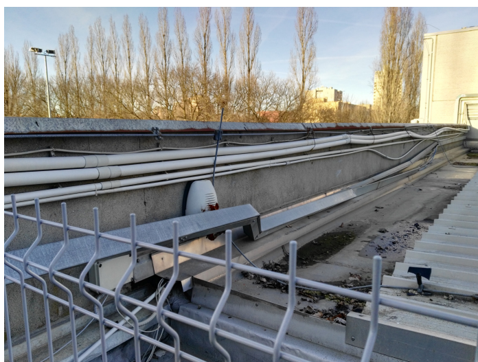
Foto 8 e 9: particolare cavi da sistemare – parete sopra ingresso bar
